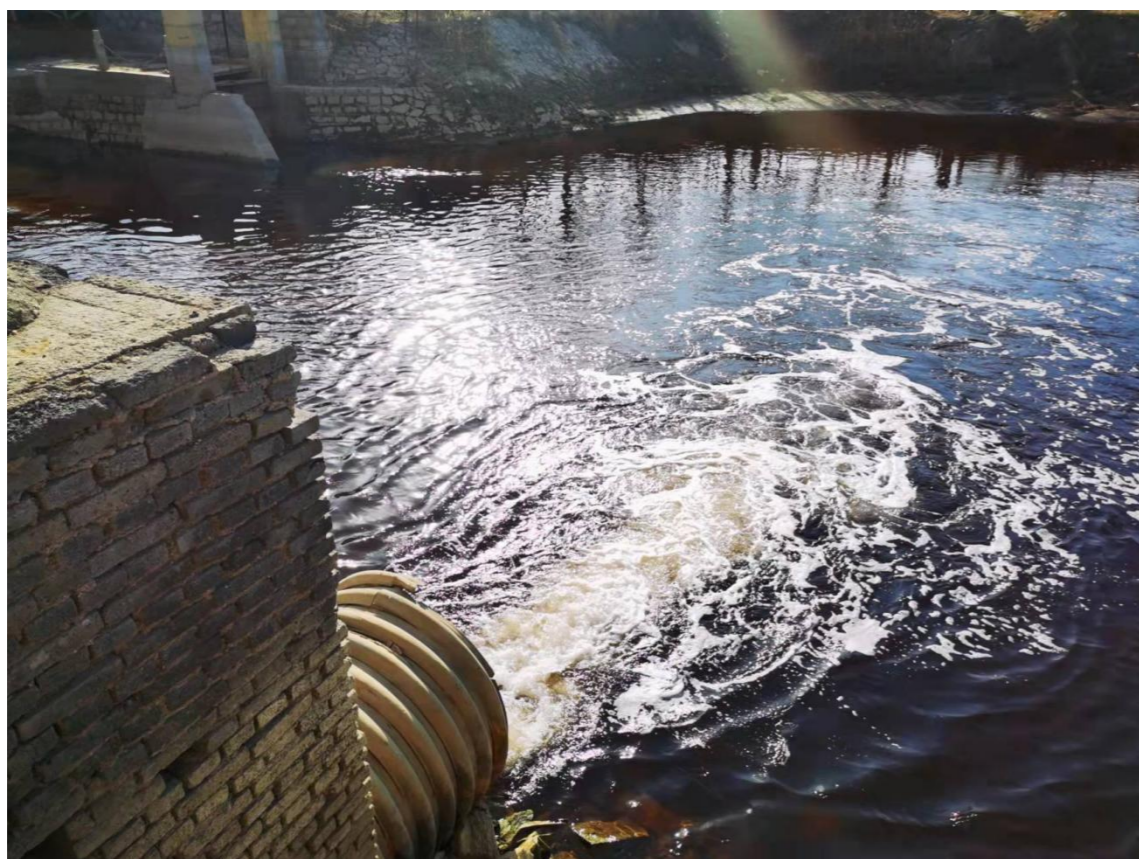
图 2-1 现状茌平污水厂尾水直排在中河
