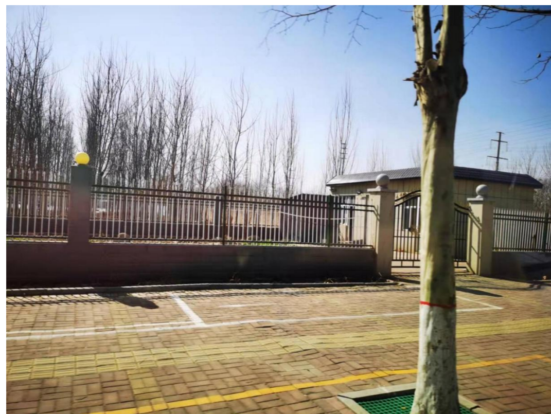
图 2-3 南水北调一期送水泵房
