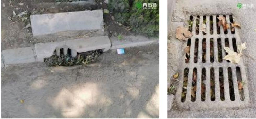
表 1.7-16 部分雨水口破损淤堵实况
