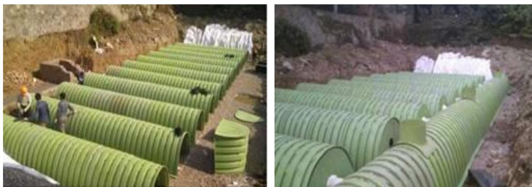
图 6.6-4 道路两侧设置的雨水调蓄设施安装图
