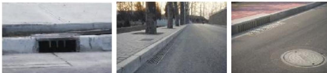
图 5.7-1 常用三种雨水口的形式（立算式、平算式及联合式）
